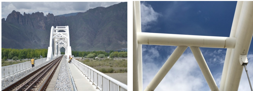
图1 拉萨河大桥2005年6月竣工图（左）与2019年8月调研时涂装情况
